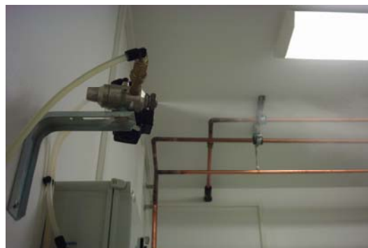
Figur 3. Befuktning av rumsluften
