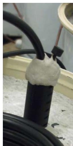
Figur 8. Mätör tätat med tätningsmassa.
